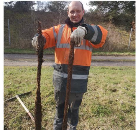
Débouchage de la conduite à l'aide de l'air comprimé, et il en est ressortit ce que l'on appelle une « queue de renard ».
